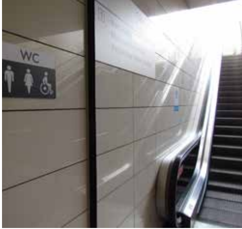
Marmaray Aynılıkçeşme İstasyonu
