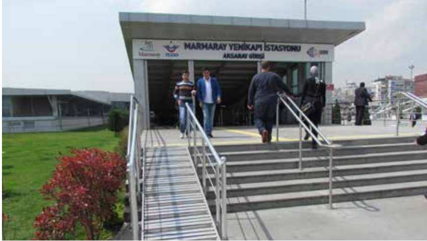
Marmaray Yenikapı İstasyonu
