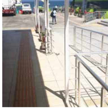
BUDO Mudanya İskelesi Engelli Rampası
