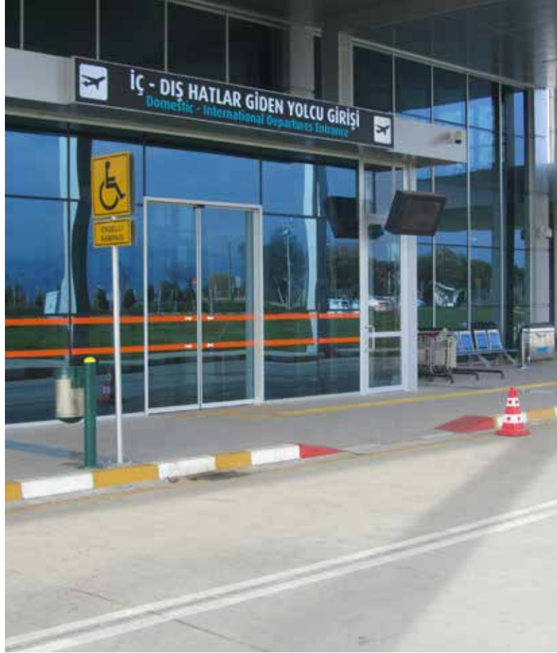
Balıkesir Koca Seyit Havalimanı Engelli Rampası
