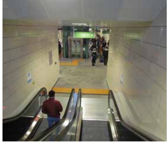
Marmaray Aynılıkçeşme İstasyonu
