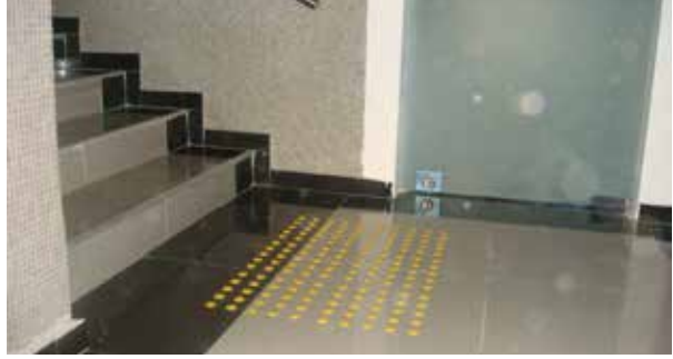
Merkez Kampüs -Merdiven Başlarındaki Hissedilebilir Yüzey Döşemeleri
