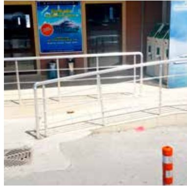
BUDO Mudanya İskelesi Engelli Rampası
