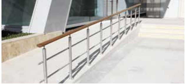
Ankara Tren Garı Engelli Rampası
