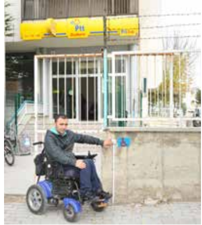
PTT Merkezi Engelli Çağrı Butonu
